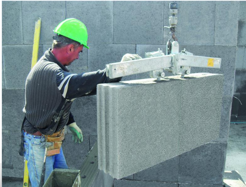
Mauerwerks- und Wandelementen aus Leichtbeton
