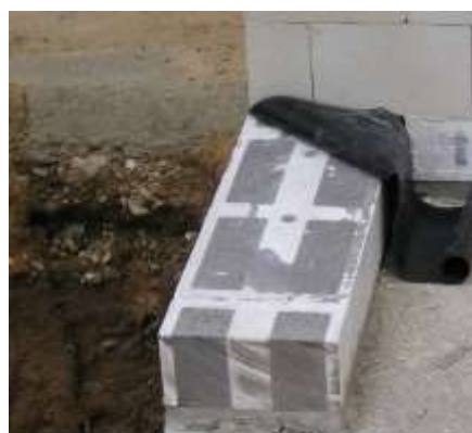
Einbau eines „Novomurs“ auf der Kellerdecke, \lambda_{eq} = 0,19 \text{ bis } 0,27 \text{ W/(mK)}
