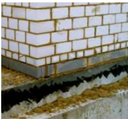
Einbau eines „KS-ISO-Kimmsteins“ auf der Kellerdecke, \lambda_{BW} = 0,33 \text{ W/(mK)}
