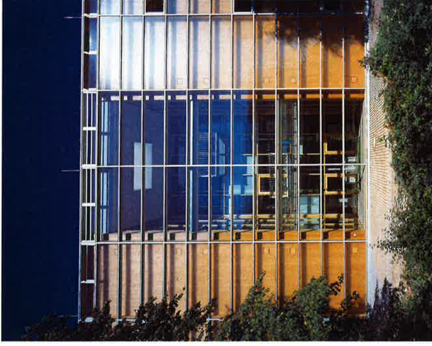
Südseite mit dem 3- geschossigen Luftkollektor - Speichermasse Holz / Energiegärten
