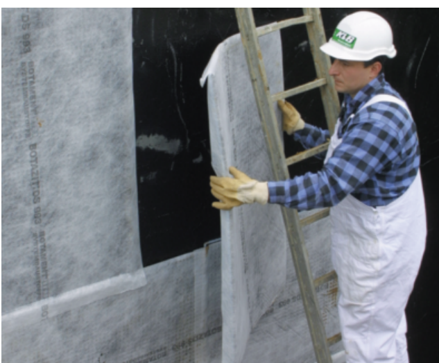
Bild 21: Abdichtung der Kellerwand.
