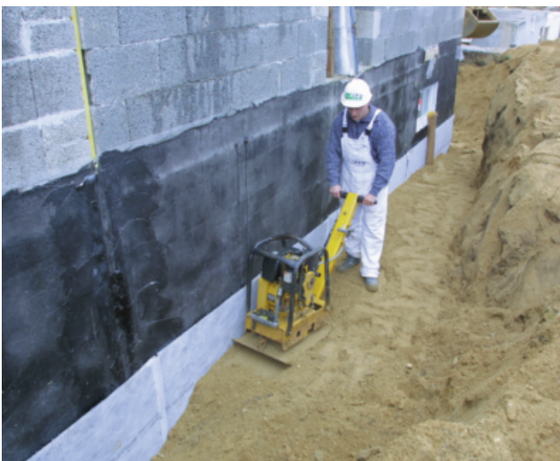
Bild 20: Verfüllung und Verdichtung der Baugrube.
