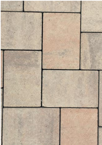
Abb. 4a: Pflastersteine mit Soffliner und Bürsten bearbeitet
